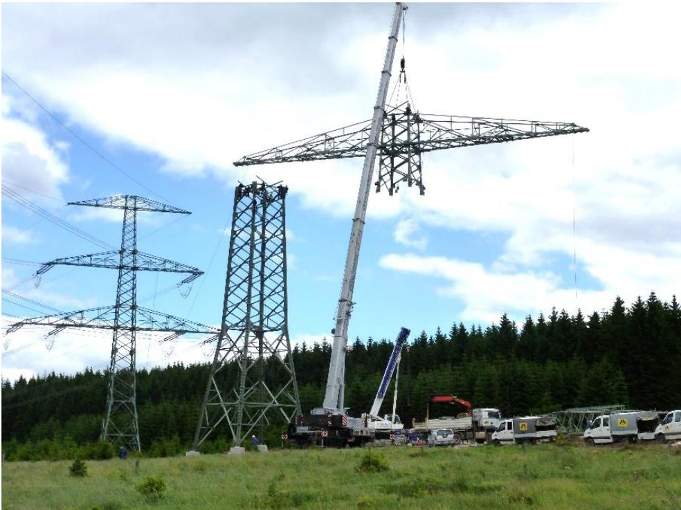
Abbildung 7: Maststocken mit Mobilkran
