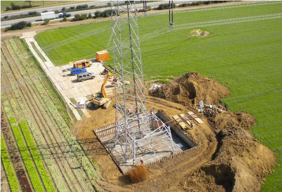
Abbildung 5: Baustelleneinrichtung mit Fundamentgrube
