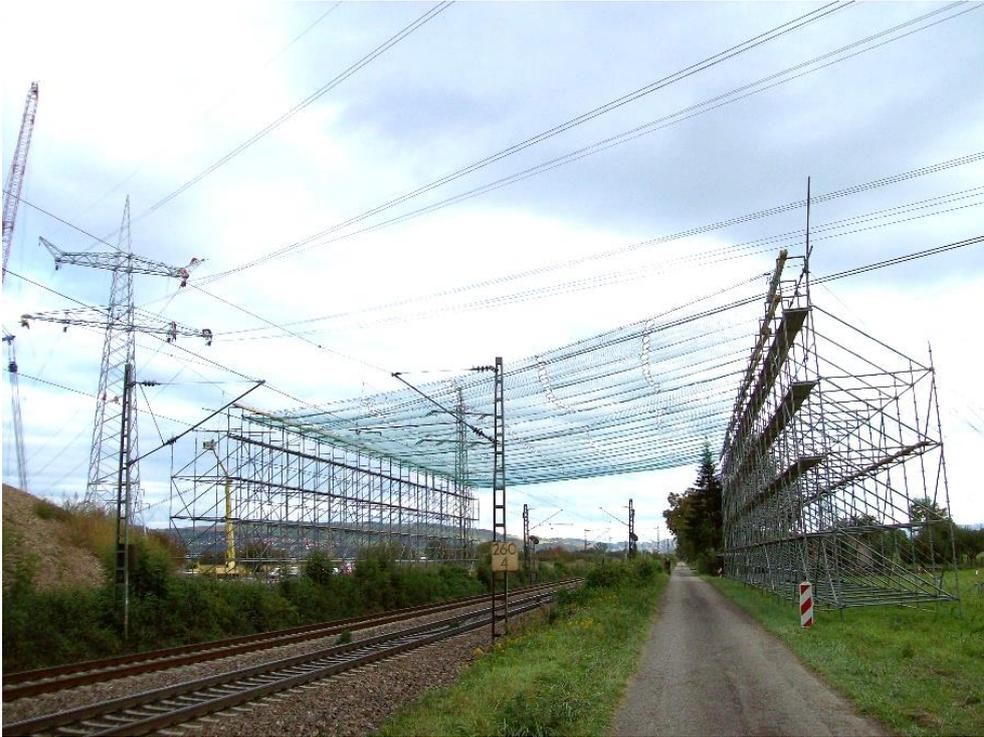
Abbildung 6: Schutzgerüst mit Netz an einer Bahntrasse
