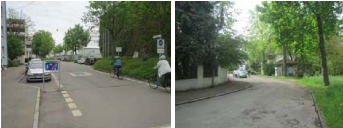
Abbildung 4-8: Ulm – Wörthstraße und Galgenbergweg (Foto: VIA eG)
