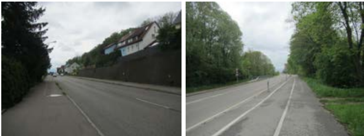
Abbildung 4-4: Blaustein - B 28 innerhalb und außerhalb der Ortschaft (Foto: VIA eG)
