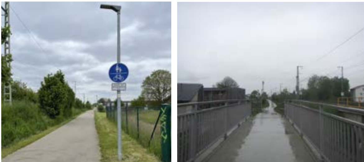
Abbildung 4-14: Erbach – Lützelried und Brückenbauwerk (Foto: VIA eG)
