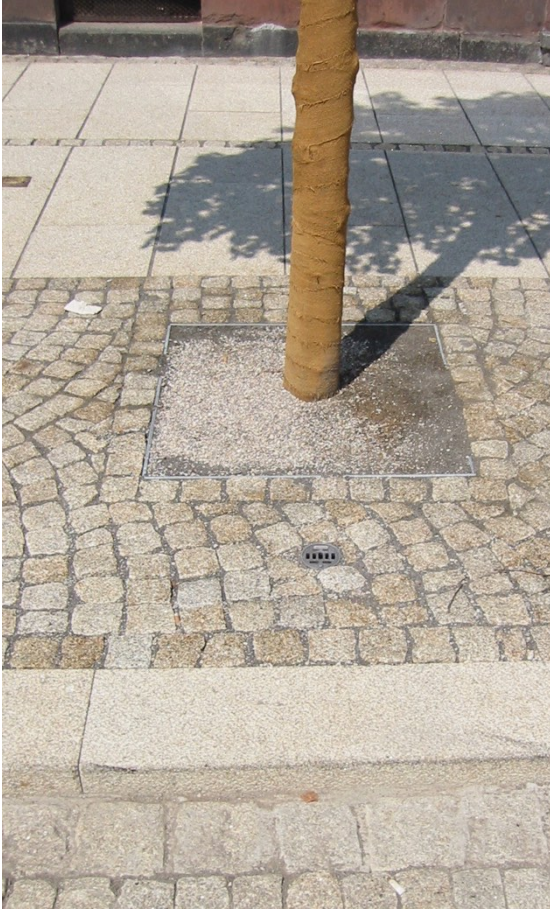
Humberg Pflanzgrubensystem Arbex Huno (2,5m x 2,5m)
