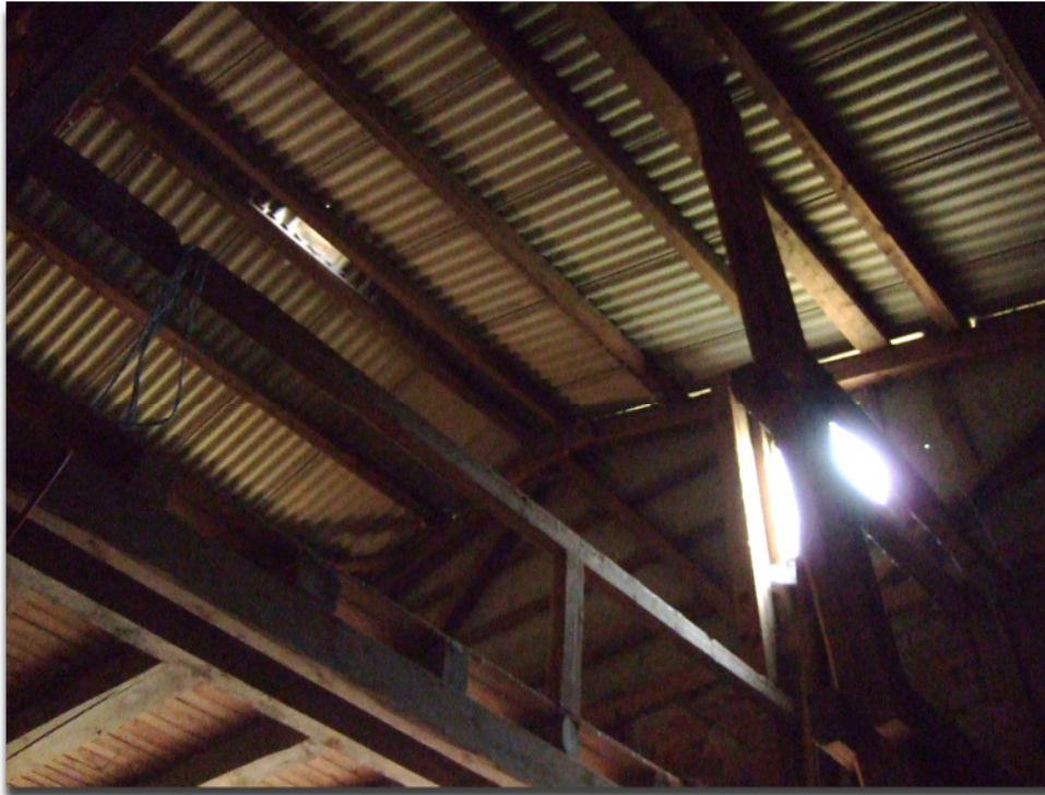
Abbildung 3: Dachkonstruktion der Scheune ohne Quartiersmöglichkeit für Fledermäuse
