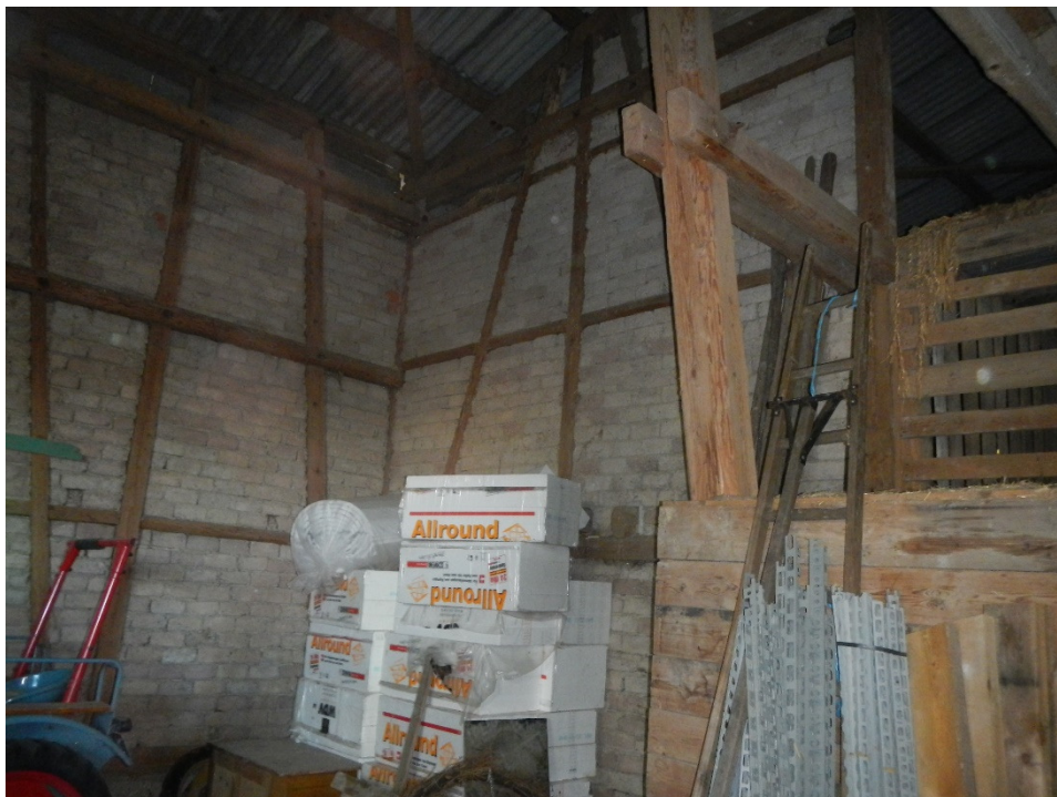
Abbildung 2: Backsteinwand der Scheune
