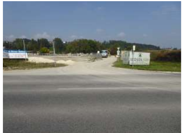
Dto. Ostseite. Rechts sind die östlich angrenzenden abgeschobenen Flächen des neuen Gewerbegebiets zu erkennen. Hier sollte darauf geachtet werden, dass während der Bau-maßnahmen keine Fallen für Eidechsen entstehen, d. h. auf der Ostseite des Steinmetz-Lagers sollte spätestens Anfang nächsten Jahres ein Reptilienzaun errichtet werden.
