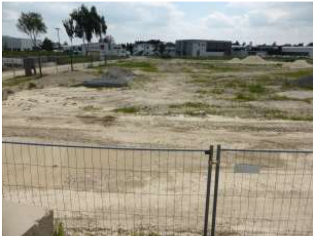
Südlicher Teil, Blick von Norden, vom Steinmetz-Lager aus: Offener, strukturarmer Lagerplatz mit kleineren Schotter-Haufen im Südteil, ...
