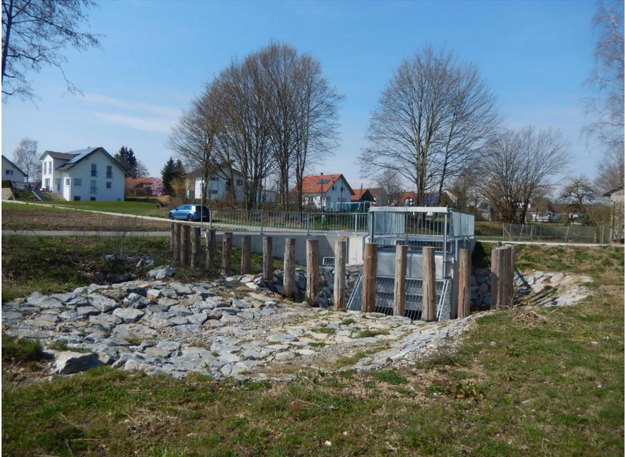
Fotos eines Grobrechens/Totholzrechens (Hochwasserrückhaltebecken Illerrieden-Wangen)
