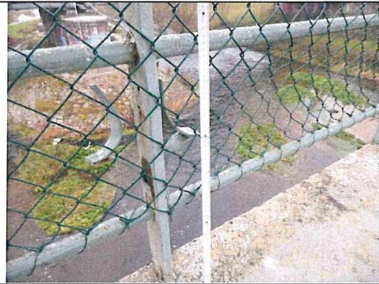
wie - 11 - Einzelteile deformiert / abgebrochen
