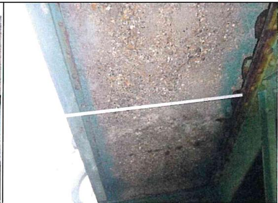
2 - Betonbalken, Randstreifen mit großflächige Betonabplatzungen an der Unterseite
