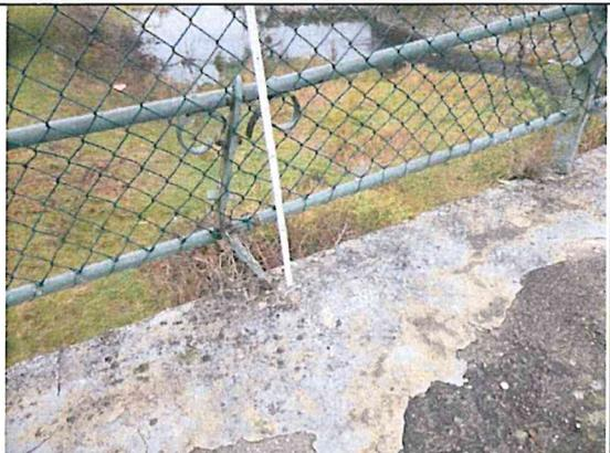
11 - Einzelteile des Geländers stark deformiert, mehrfach
