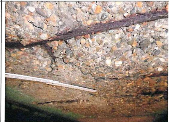
4 - Beton des Randstreifens großflächig abgängig, Querschnittsverlust der Betonstahlbewehrung
