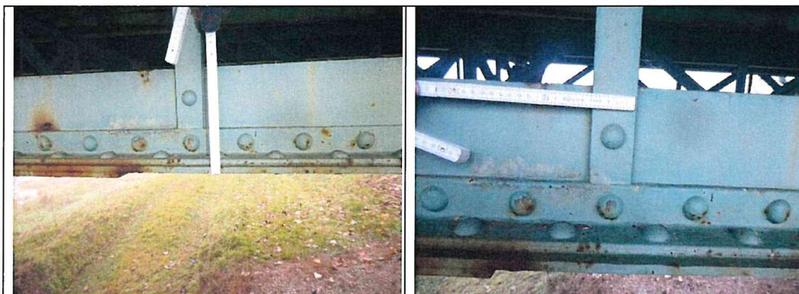
1 - Untergurt des Hauptträgers, einzelne Roststellen, instandsetzbar, SK 2
