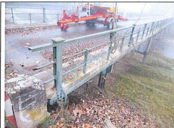
1- Einzelne Profile total verrostet, Drahtgitter Füllung, Stahlprofil in den Beton Randstreifen einbetoniert
