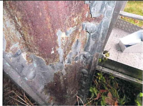
2 - Ansicht Rammpfahl, SK 3, Beschichtungsstoff beprobt, teerfrei
