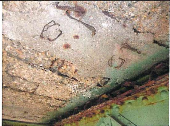
7 - Großflächig Betonabplatzungen
