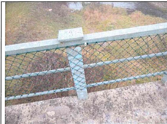
3 - Geländerpfosten, Hauptpfosten, Rostansatz unmittelbar unter dem Abdeckblech oben, SK 1, Drahtgitterfüllung ist nicht original
