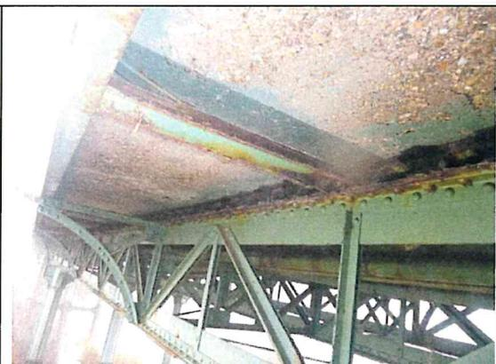
2- Geländer Querträger, SK 2, Querträger als Teil des Tonnengewölbes ist abgängig, SK 5
