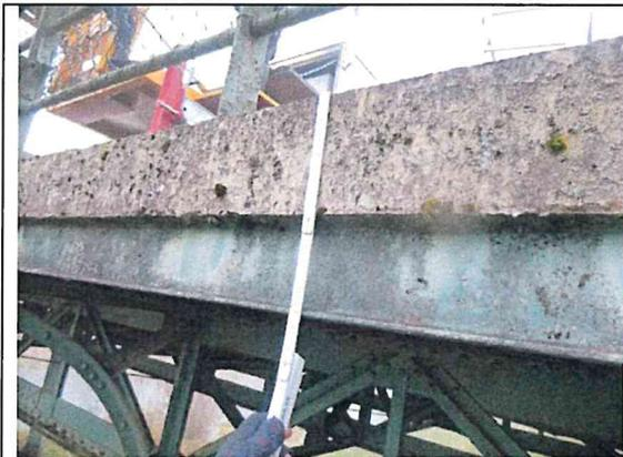
1 - Randträger unter dem Beton Gesims, zusammen mit dem Betonbalken nachträglich eingebaut, SK 2
